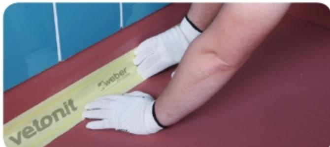
Необходимо нанести не менее 2 слоев: сначала на основание наносится слой розового цвета, а после его высыхания (через 3 часа при +20 °C и влажности воздуха 50 %) наносится слой серого цвета.
